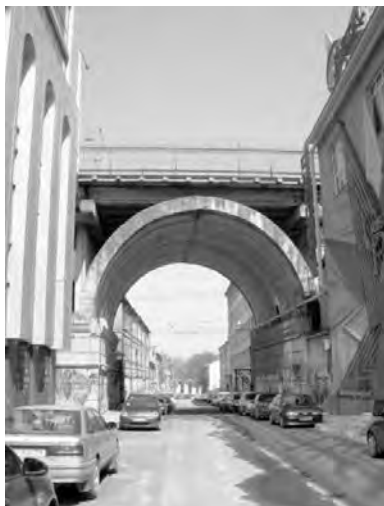
Строгановский мост после реконструкции (фрагмент)
